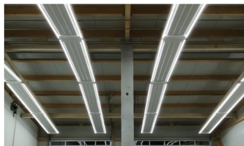
Selbst bei einer Schrägmontage der Deckenstrahlplatten lassen sich die LED-Leuchten jetzt ganz einfach fixieren. – © RMBH GmbH, Herrieden
